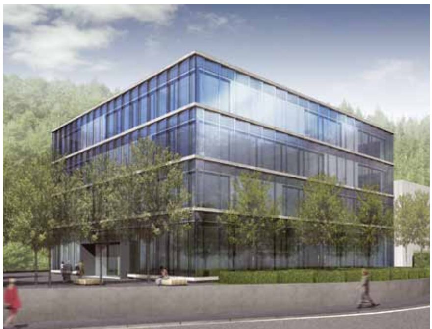
Abb. 17: Centro Svizzero di Calcolo Scientifico (CSCS) der ETHZ, in Manno bei Lugano (in Realisierung)
